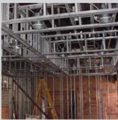
Light-Gauge Stud Framing
